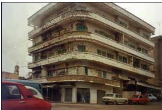
Κτίριο στὴν Ἀνατολική Βηρυττό κατεστραμμένο ἀπὸ τὸν πόλεμο
