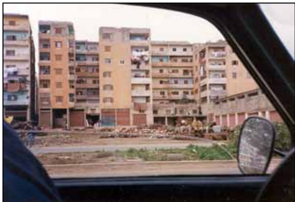
Τρίπολη Λιβάνου. Κτίρια κατεστραμμένα ἀπὸ τόν πόλεμο
